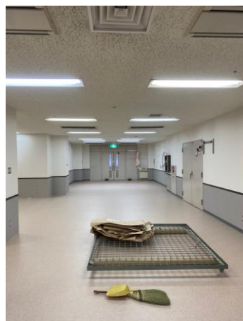
本館リハビリ室 の改修
